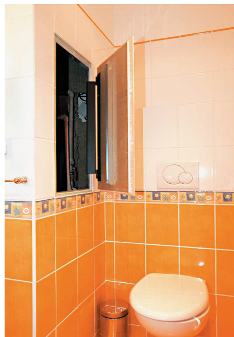
Dvířka pro zavírání instalační šachty se montují přímo pod obklad a zavřená nejsou téměř vidět, přizpůsobují se stavu stoupaček i velikosti obkladu.
