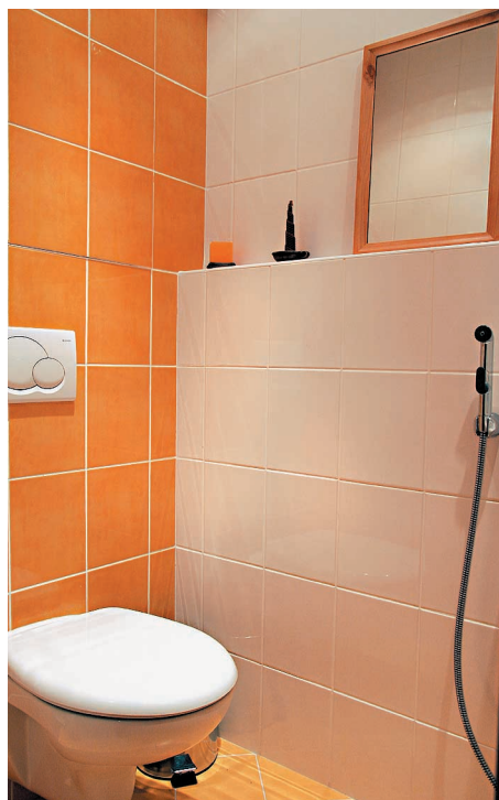
Na záchodech je vhodné instalovat místo bidetu všestrannou bidetovou spršku.
