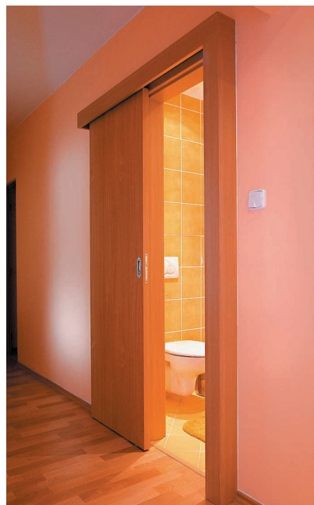
Instalace zasouvacích dveří do kovového pouzdra se vyplatila.
