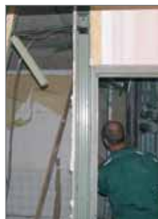
1. den – demontáž původního jádra
