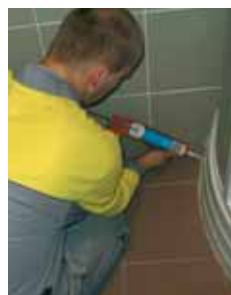
6. den – aplikace silikonové izolace
