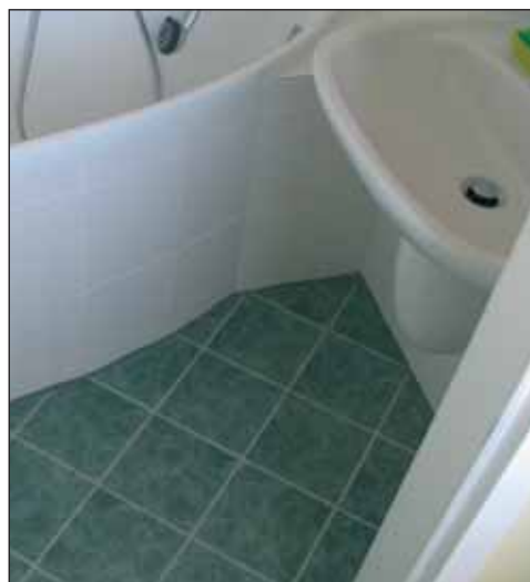
7. den – dokončovací práce
