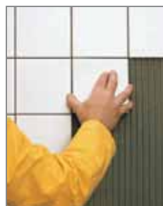
4. den – montáž obkladu
