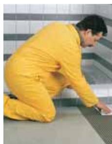
5. den – montáž obkladu a dlažby
